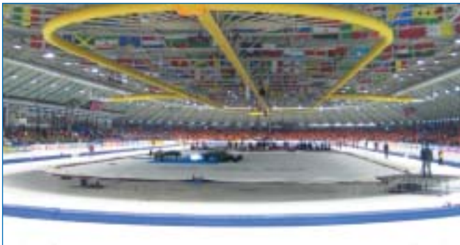
Energiebesparing door waterkoeling in Thialf
